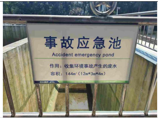
事故池（位于污水站）（容积144m 3 ）
